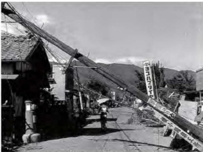
電柱などが道路をふさぎ、通行不能になった甲府一静岡線
