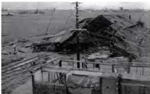
倒壊した「ボロ電」の車庫（甲府市・昭和34年） 車庫の屋根がべしゃんこになっている。手前の建物も壁が残った程度。左端に男性がひとり立っているが、この光景に呆然としているようだ。
