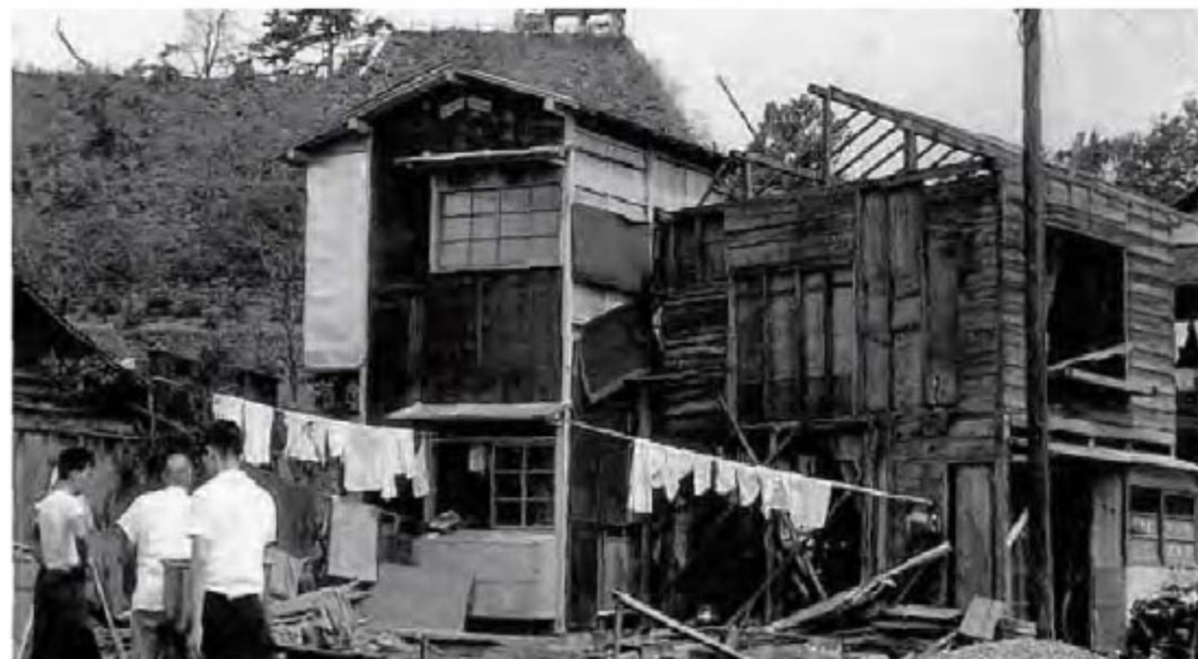
吹き飛ばされた舞鶴城公園東側の民家の様子
